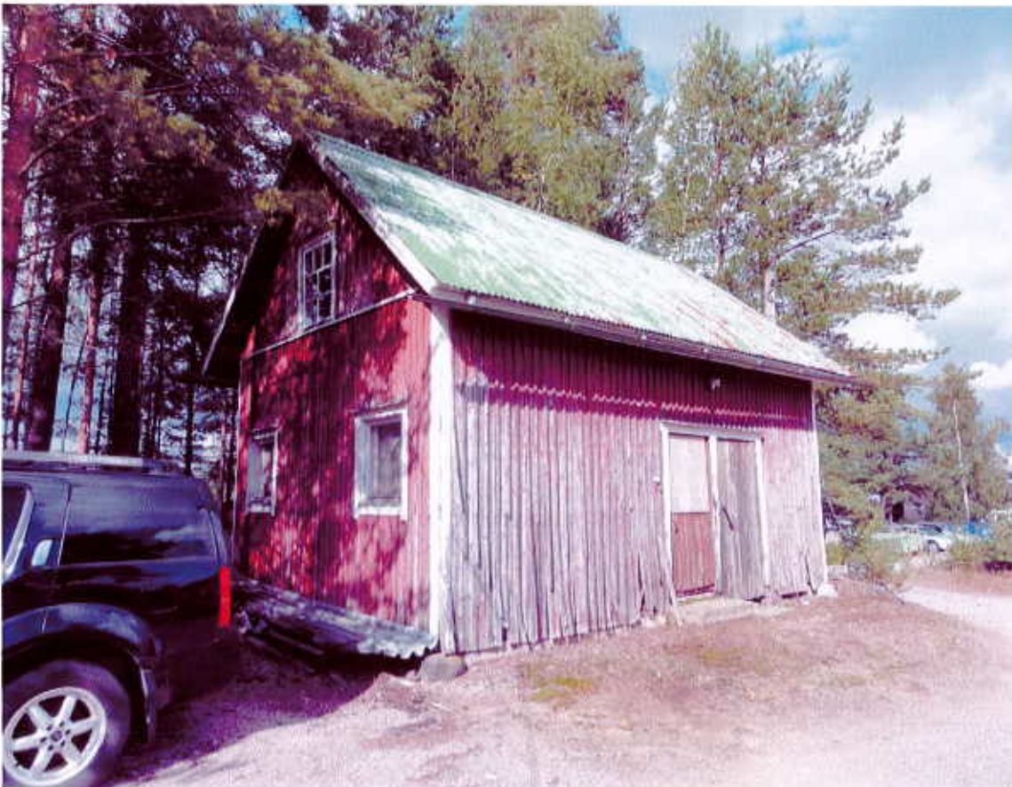
Korvenrannan pihapiirissä oleva lautarakenteinen talousrakennus 2017.
