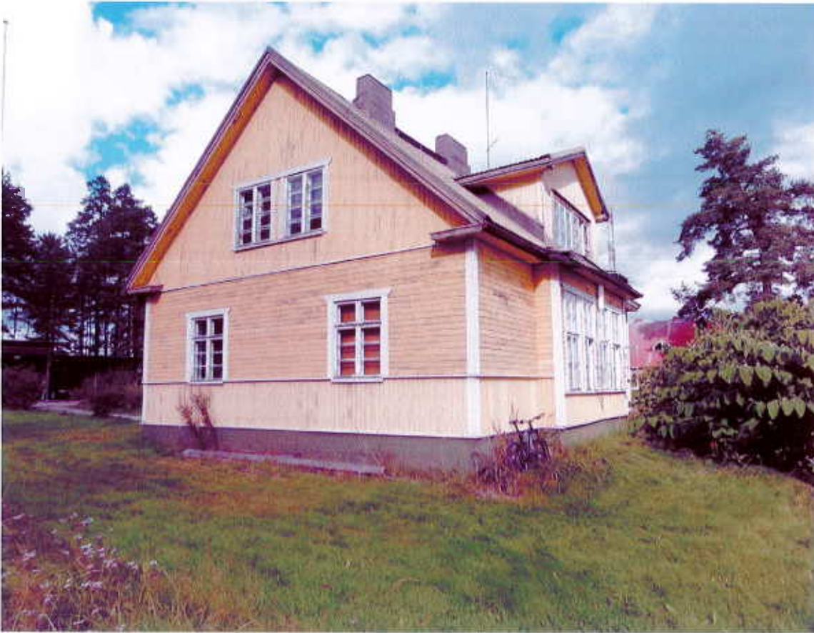
Korvenrannan asuinrakennus etelästä 2017.
